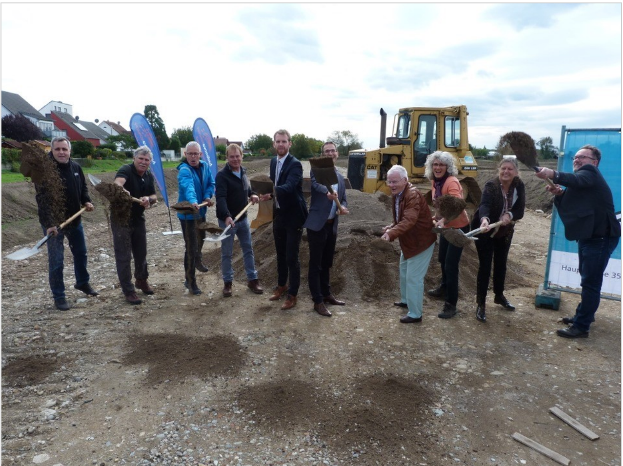
Erster Spatenstich für das neue Ihringer Baugebiet Foto: Christine Weirich
