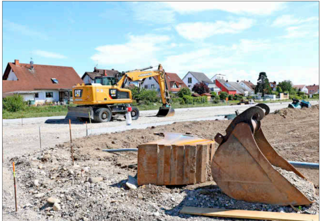
Die Arbeiten für das neue Ihringer Baugebiet „Kaibengasse“ gehen voran.
